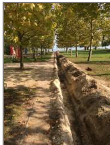
A közlekedő felújítás alatt
