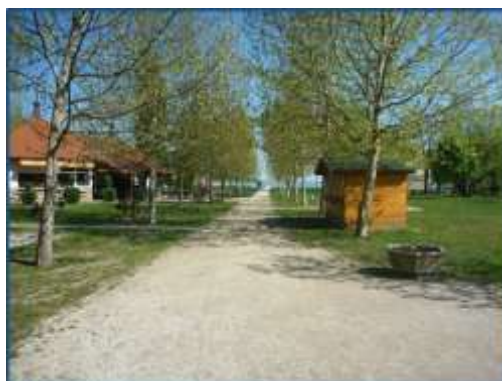
A közlekedő felújítása (térkövezés)
