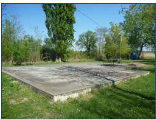
Meglévő betonlap elbontása (fűves terület kialakítása)
