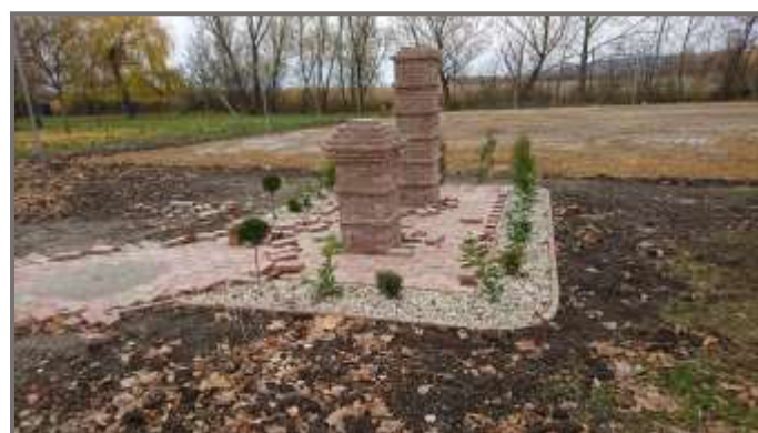
Épülő kültéri ivókút és zuhanyzó
