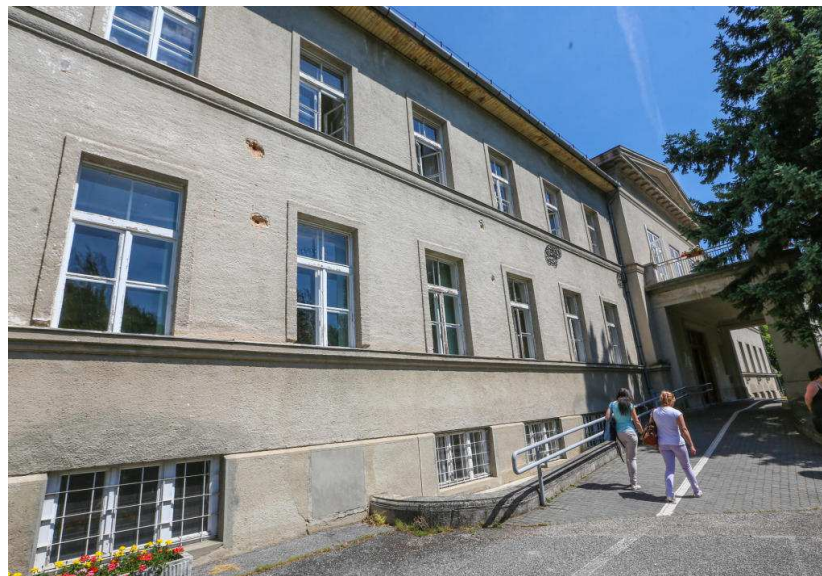
Felújítják és szigetelik a balatonfüzfi városháza homlokzatát, a munkálatok év végén kezdődhetnek el Fotó: Penovác Károly
